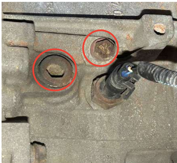
Oxidação nos parafusos do motor
