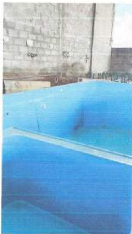
PISCINA NA FABRICA SENDO CONSERTADA
